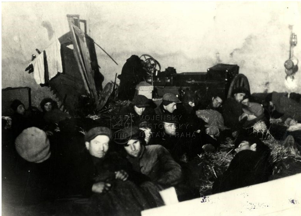
Ubytování Čechů totálně nasazených na zákopové práce (archív Historického vojenského ústavu Praha)
