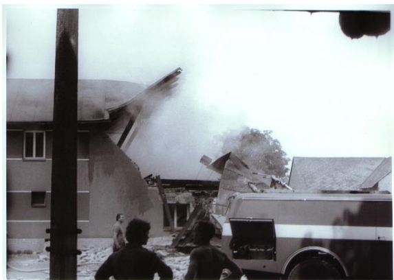
Zásah požárníku v troskách statku Kabešových. (foto J. Kuntoš)
