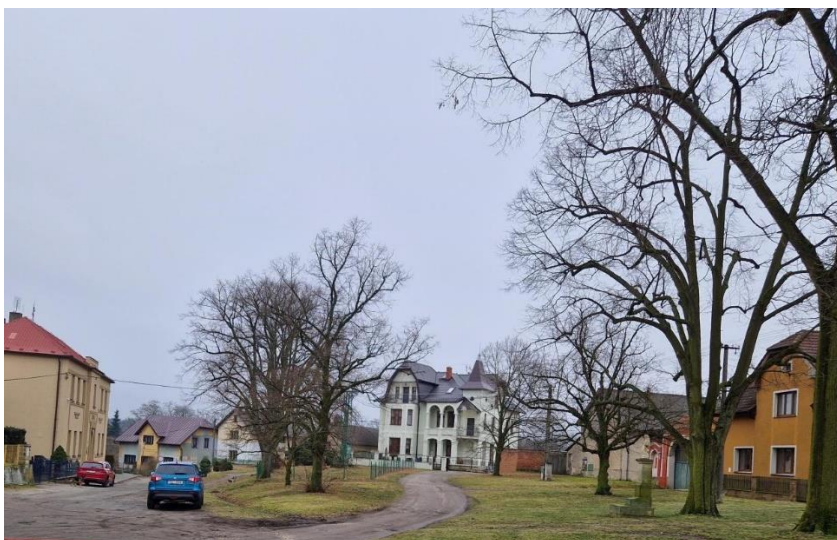
Ještě jeden pohled na náves v Čisté, v části obce zvané „Velká strana“, tentokrát z opačného směru. Letadlo se zřítilo úhlopříčně na obrázku zprava, jinak ze severozápadu. Dům úplně vlevo je škola, bílá vila uprostřed mezi stromy je bývalá „Machova vila“, místo, kde v osudný okamžik byl pan učitel Filip s dětmi v družině, na což vzpomínala paní Veselá. (foto J. Štěpán)
