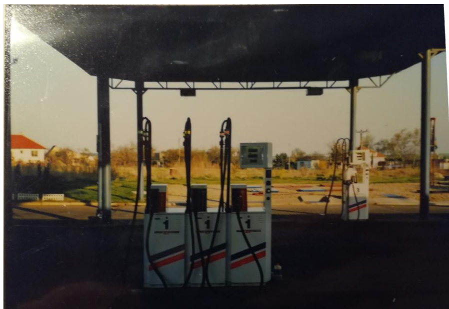
Čerpací stanice TPC v Byšicích
